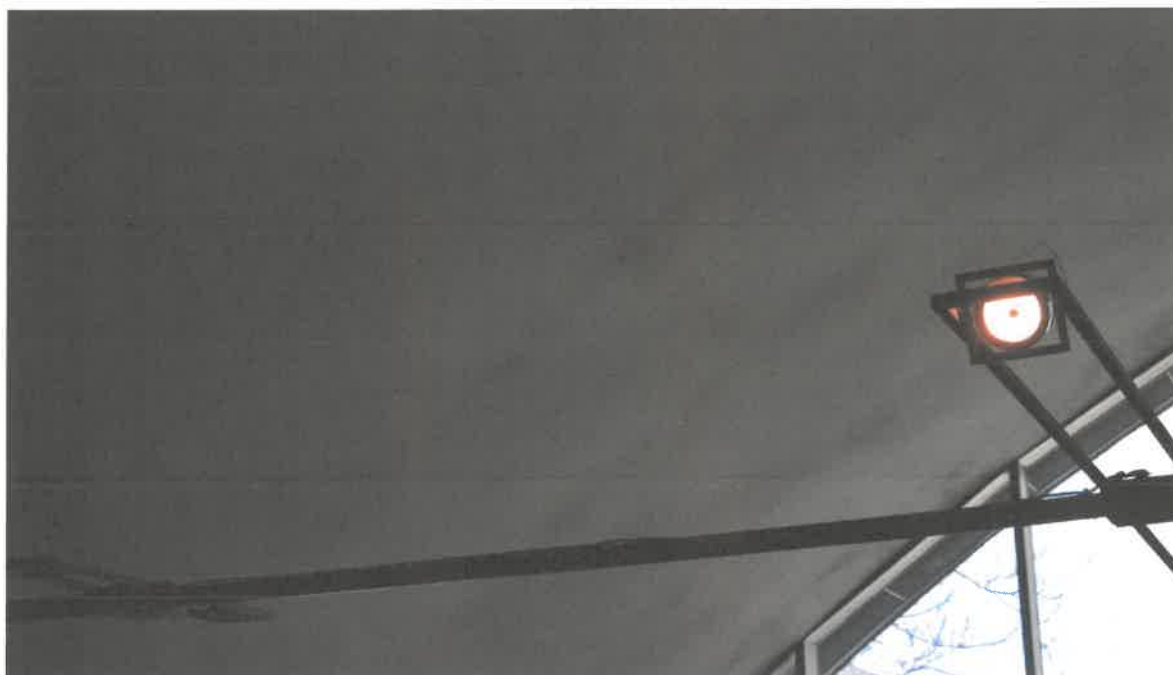
Fot. 12 –ciemne smugi na suficie spowodowane brakiem szczelności izolacji termicznej i paroizolacji w przegrodach stropodachu.
