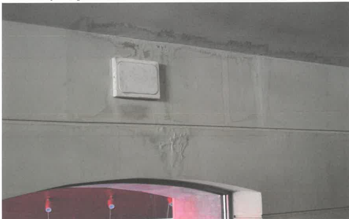
Fot. 1. Łuszczenie się warstw farby na skutek przenikania wilgoci z wnętrza przegrody, [skrzyżowanie osi K/27]
