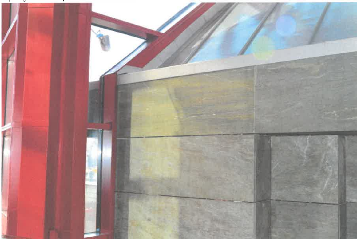
Fot. 13 –narożnik styku ściany osłonowej ze ścianą budynku D –elementy kamienne i ofasowanie do demontażu na czas ponownego uszczelnienia przegrody.
