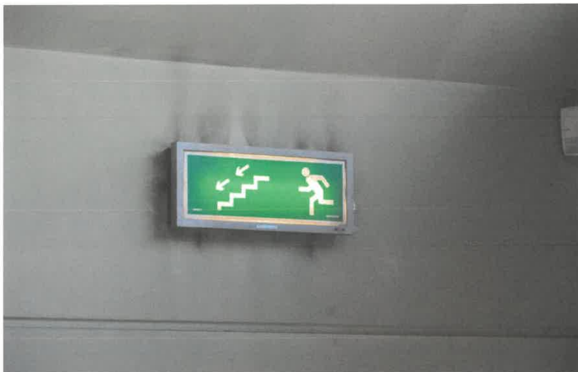
Fot. 8 – ślady wydostawania się powietrza spod oprawy ewakuacyjnej –ściana południowa
