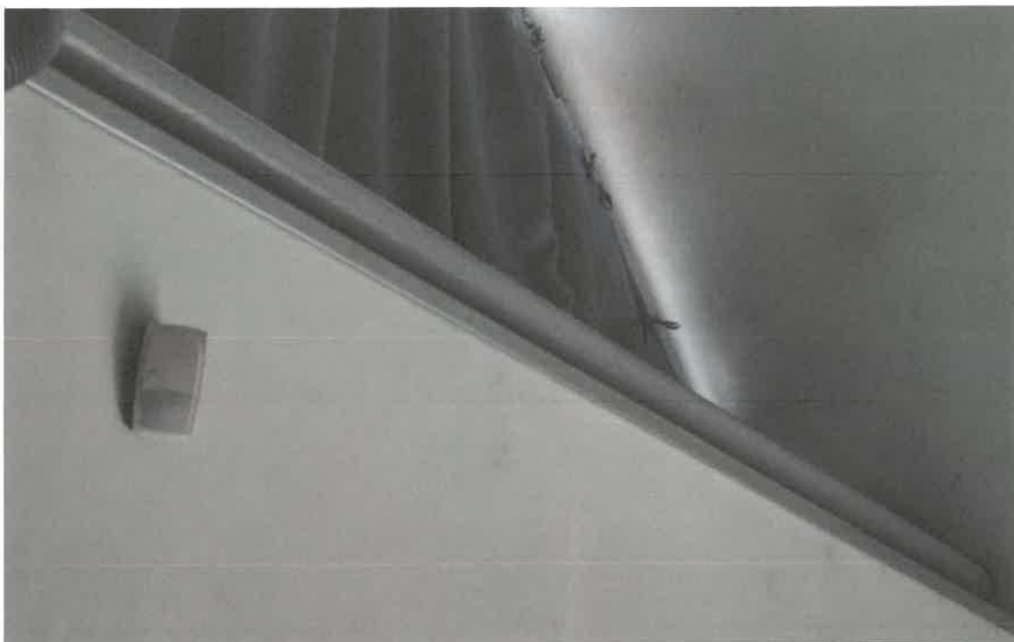
Fot. 5 –śląd przenikania powietrza zewnętrznego przez warstwy stropodachu przy ścianie szczytowej –strona południowo-wschodnia.
