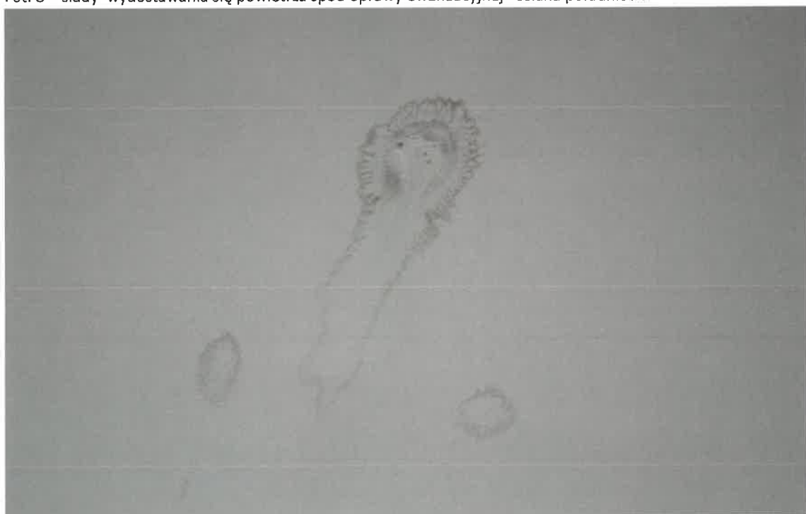
Fot. 10 –wykwity na suficie spowodowane brakiem szczelności izolacji termicznej i paroizolacji w przegrodach stropodachu
