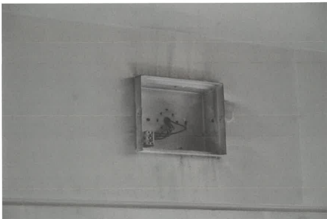
Fot. 7-8 – smugi – ślady wydostawania się powietrza spod głośników wbudowanych w ściany
