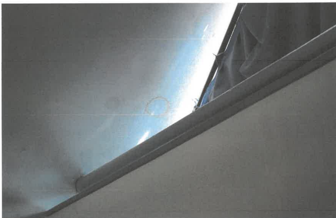
Fot. 4 –wykwyty wilgoci na suficie przy ścianie szczytowej –strona północno-wschodnia
